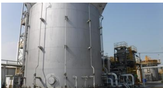
原料槽體、管線地上化、定期巡檢
