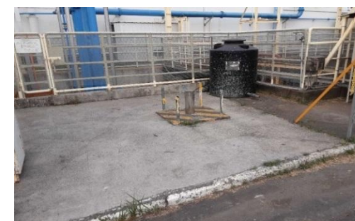
地下廢水槽旁設置自主監測井
