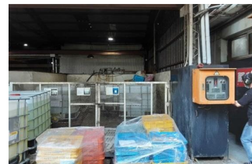
原重油槽曾發生洩漏遭開罰
