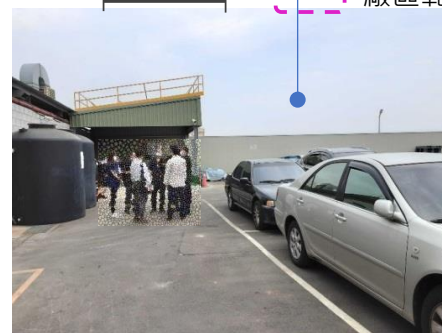
舊原物料貯存區(火災曾發生位置)
