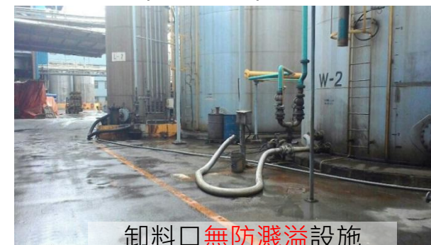
原料(有機溶劑)地下貯存槽
