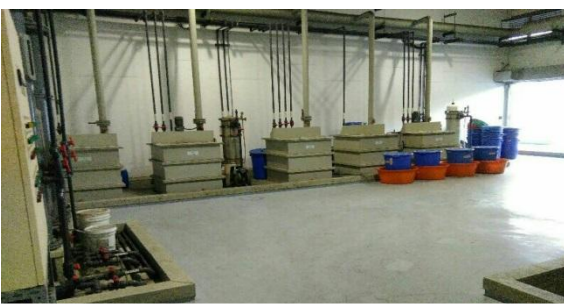
製程區鋪面完整、設備地上化、進出料管理妥善
