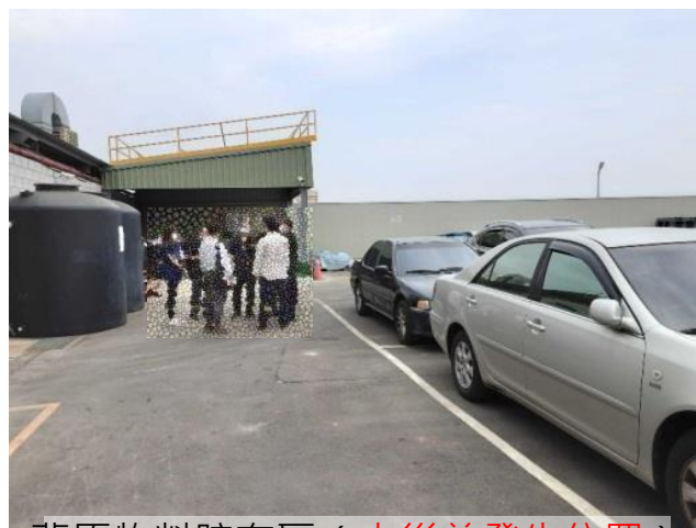
舊原物料貯存區 (火災曾發生位置)
