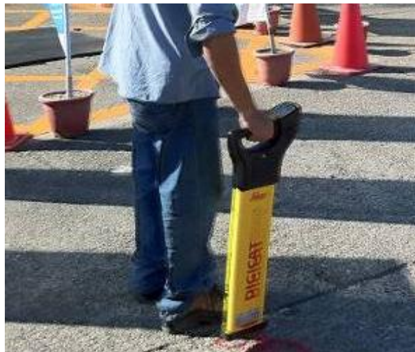
管線探測儀探測 (電管)
