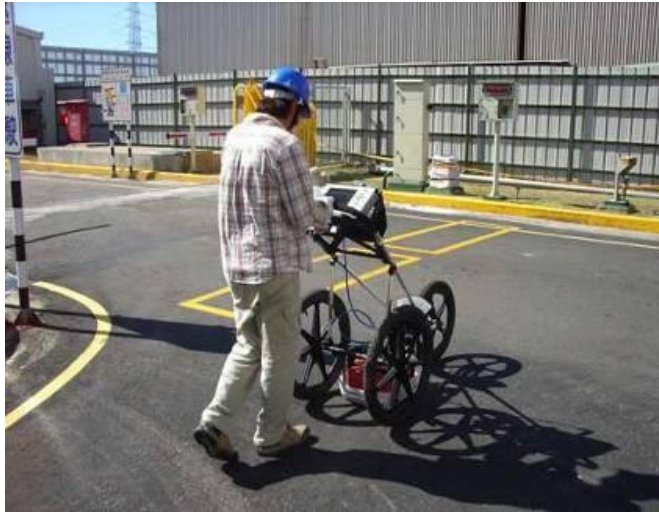
透地雷達探測 (地表下3公尺內各式管線)
