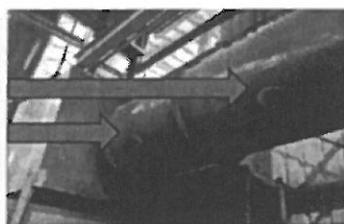
支管開口未配管，僅以布罩綁住，且破損漏氣，影響支管排氣量，建議應加裝風門，做好盲封，或汰換新機
