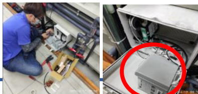
感測器信號轉換器施工 感測器信號轉換器
