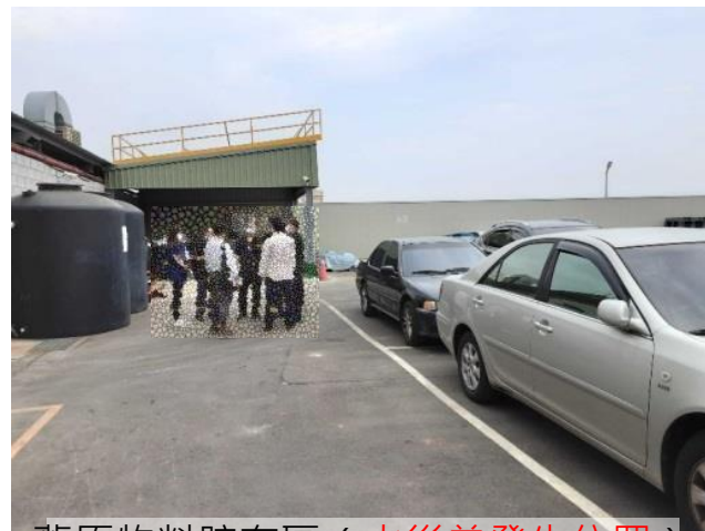
舊原物料貯存區 (火災曾發生位置)
