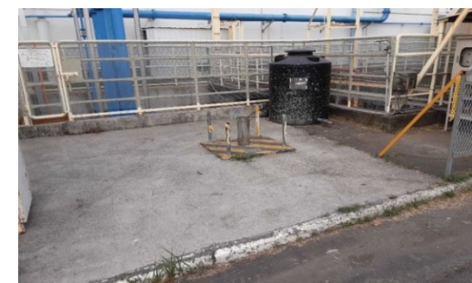
地下廢水槽旁設置自主監測井 36
