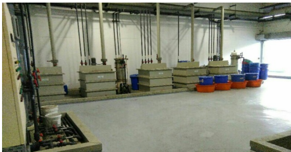
製程區鋪面完整、設備地上化、進出料管理妥善
