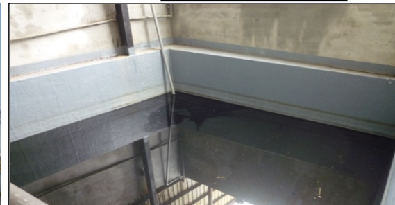
廢水槽RC結構內覆防滲層
